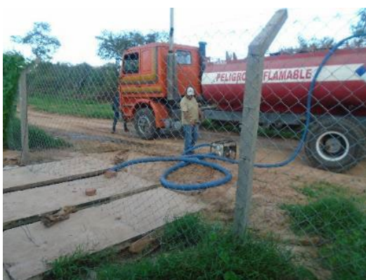
Limpieza de fosa séptica
