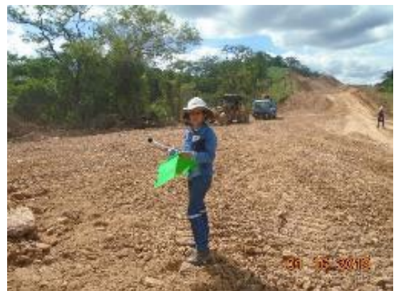
Monitoreo de ruido en el terraplén
