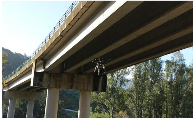
Imagen 9: Uso de Dron en evaluación de estructura de puente
