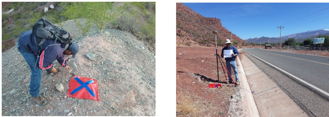
Imagen 26: Colocación de puntos de control terrestre GCP
