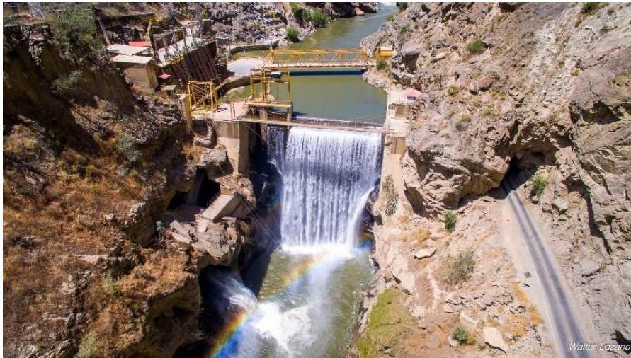
Imagen 11: Obras Civiles a vista de Dron, Cañón del Pato, Huaraz
