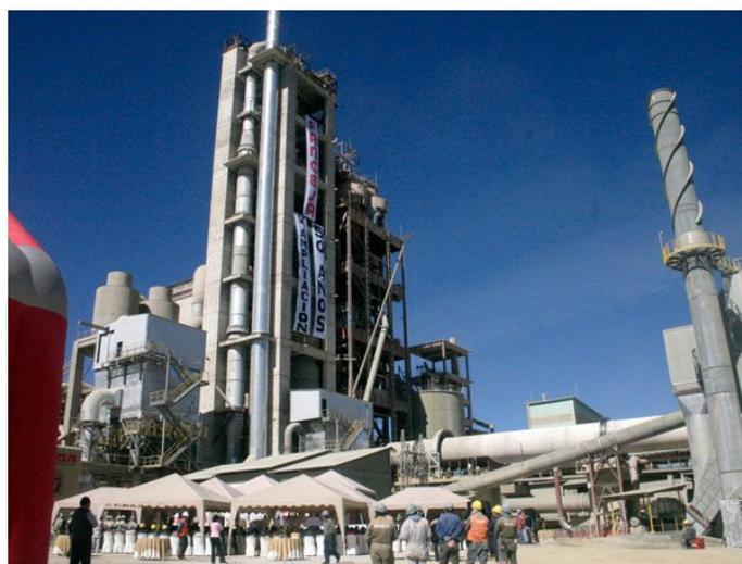
Figura 3.1: Horno Rotatorio - Torre DOPOL y SLC
