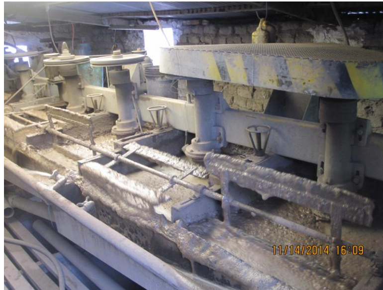
IMAGEN 1. Celdas de Flotación
