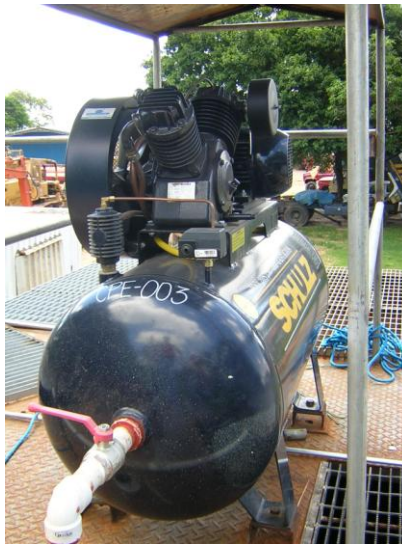
Figura 8.5.- Fotografía del compresor de la planta de lodos activados de IST Ltda
