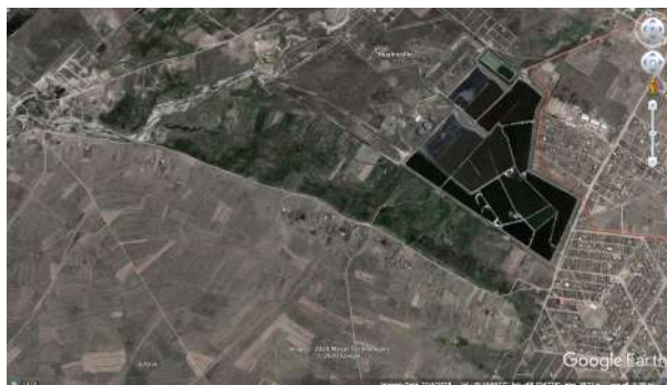
Figura 1-16 – PTAR de Puchukollo construida en 1998 para 500.000 habitantes. Actualmente, trata ineficientemente la contaminación doméstica (> 1 M hab.) e industrial con 15 lagunas: 5 anaerobias, 4 facultativas, 4 de maduración, 2 de pulimento; en ampliación y mejoramiento. Cubre 60% de El Alto. Su efluente es vertido en el río Seque. Fuente: PNUMA (2011).
