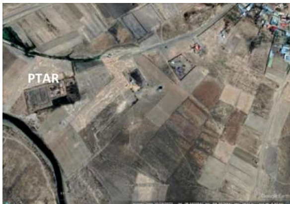
Figura 1-17 – La PTAR de Laja fue construida en 2010 para 20.000 habitantes (hoy > 25.000 hab.). Su tratamiento primario se realiza en un tanque de sedimentación, luego en un tratamiento biológico en lagunas de totorales. Cubre 60% de la población. Su efluente es vertido en el río Pallina. Fuente: ALT (2014).
